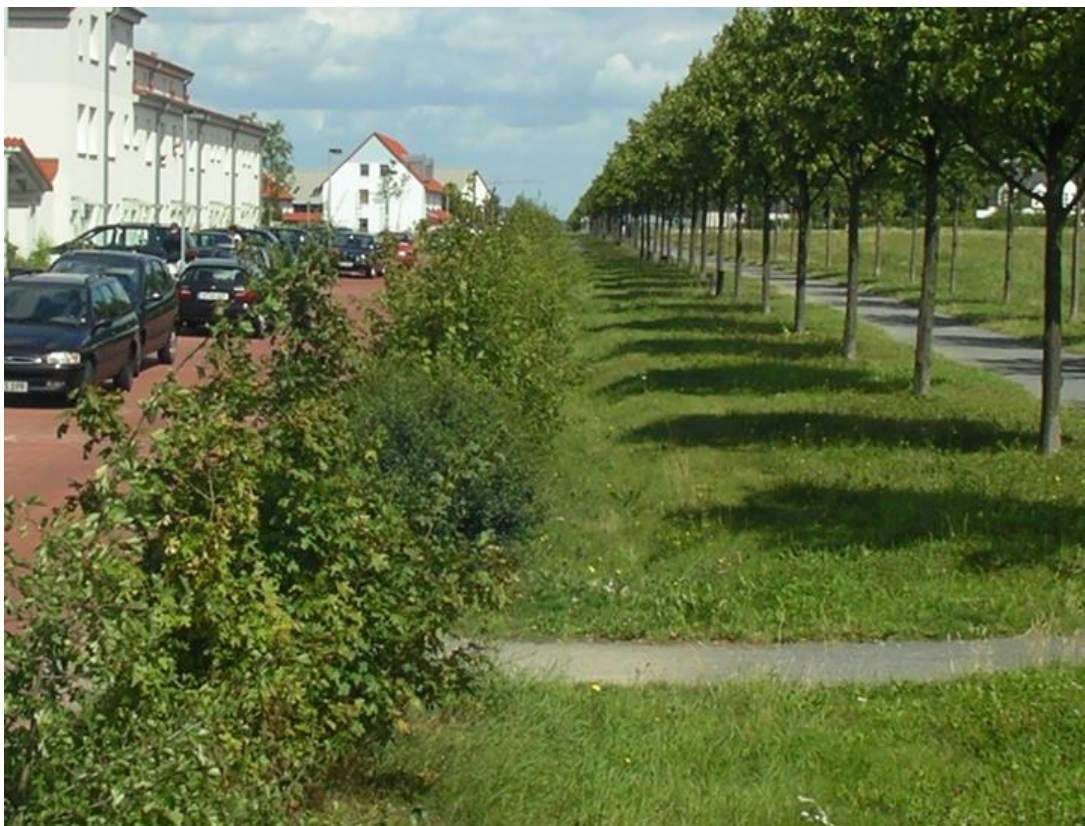
Retentionsgraben (Foto: Mathias Uhl)
