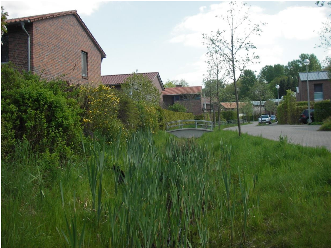
Retentionsgraben (Foto: Mathias Uhl)
