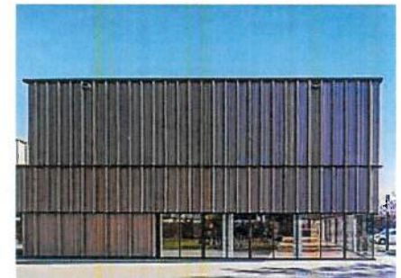
Abb. 129 Nachbarschaftshaus mit Kita, Mainz, AV1 Architekten Das großzügige Erdgeschoss mit seiner Fensterfront wirkt einladend
