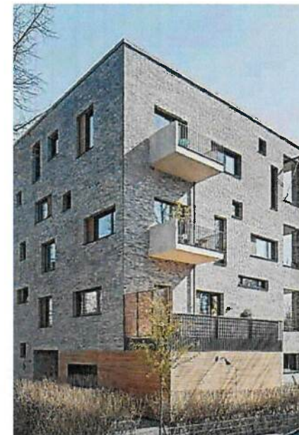
Abb. 117 Mehrfamilienhaus, Hamburg, kbnk Architekten Nachhaltiger Massivbau einer Baugruppe
