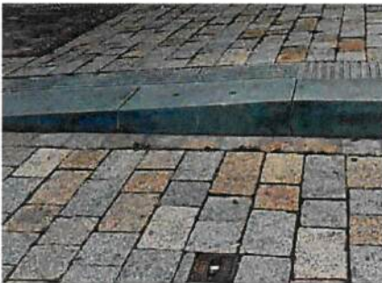
Abb. 122 Bushaltestelle integriert, haefner jiménez betcke jarosch Die Erhöhung des Bordsteins markiert die Bushaltestelle im Shared Space
