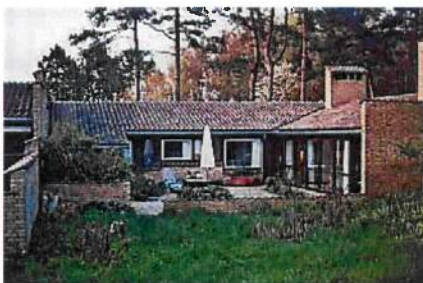
Abb. 79 Kingohusene, Helsingør, Jørn Utzon Die private Terrasse ist das „Herz“ des Patiohauses.
