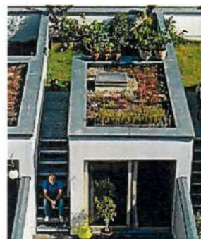
Abb. 85 ze05, Berlin, zandarrath architekten Intensiv und extensiv begrünter Dachgarten
