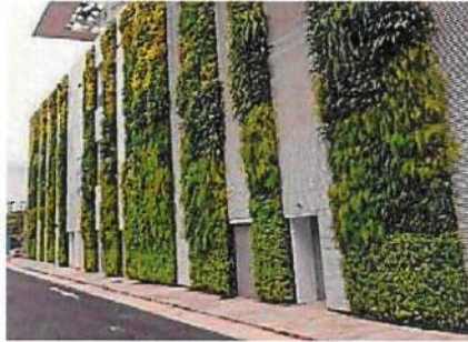
Abb. 131 Vertikales Grün Die üppige Begrünung der Fassade ist ein Blickfang
