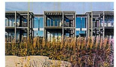
Abb. 99 Lovedon Fields, Kings Worthy, John Pardey Architects Tür an Tür wohnen mit den Nachbarn
