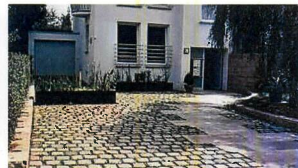
Abb. 82 Unverfugtes Natursteinpflaster unterstützte die Regenwasserretention auf dem Grundstück
