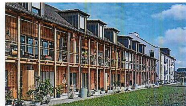
Abb. 86 Wohnsiedlung, Orenberg Ossingen/ CHE, BDE-Architekten Das Reihenhäuser aus Holz als Blickfang im Quartier
