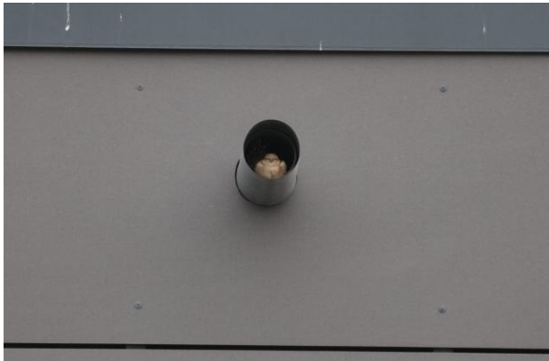
Abbildung 10: Weiblicher Haussperling ruhend im Regenrohr an der Gebäudefassade, Kraus (April 2026)
