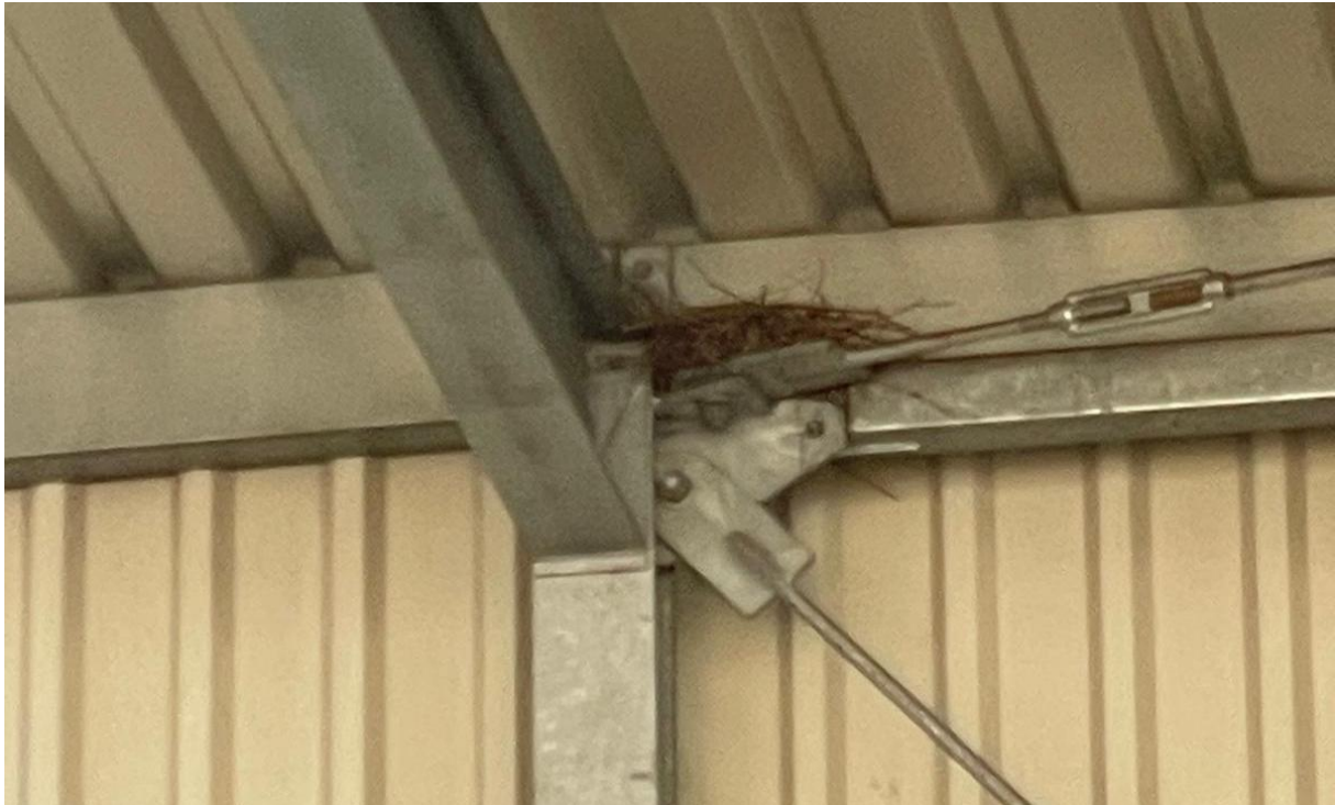
Abb. 10: Nest auf der Trägerkonstruktion der offenen Lagerhalle, Quelle: Kraus, 2026
