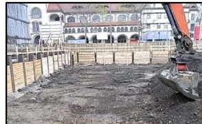
Abb. 4. Schichtenweiser Abtrag, verpflichtend bei baubegleitender KMR
