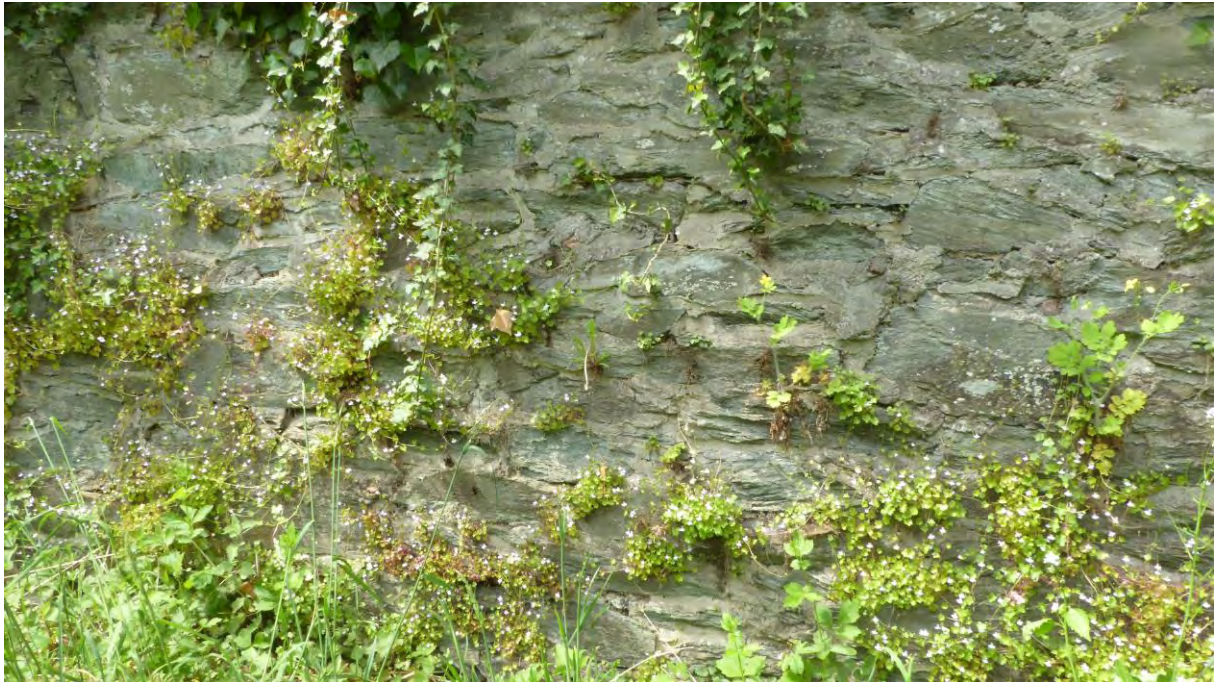
Abbildung 16: Verfugte Bruchsteinmauer, Kraus 2022
