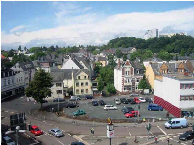
Ein räumlicher Abschluss fehlt hier.
